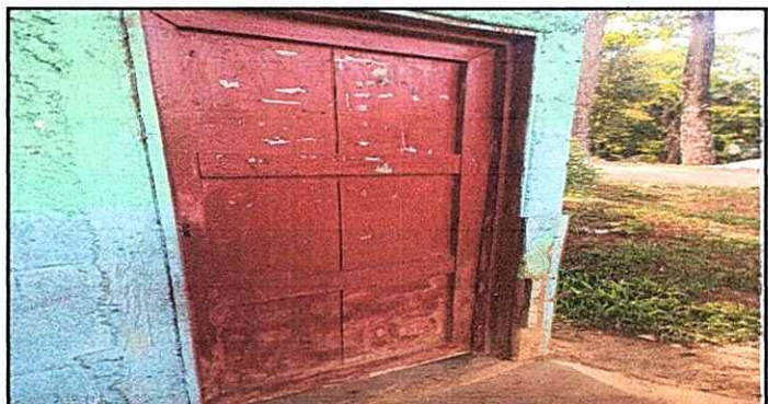
Foto 6: Aquí puede observarse el estado de las puertas que ya necesitan cambio.
