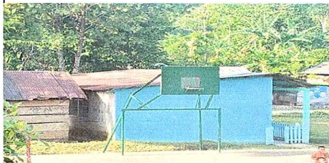
FOTO 6. Se muestra el estado de la pared
